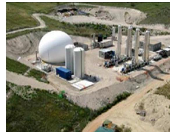
Incremento de la recuperación de materiales con nuevas líneas de selección, puesta en marcha de instalaciones de compostaje complementadas con la progresiva implementación de la recogida selectiva de la fracción orgánica en el municipio. Mejora del rendimiento de la Planta de Tratamiento de Biogás (PTB) incrementando la producción de biometano, y aprovechamiento energético con generación eléctrica del biogás no destinado a inyección a red.
